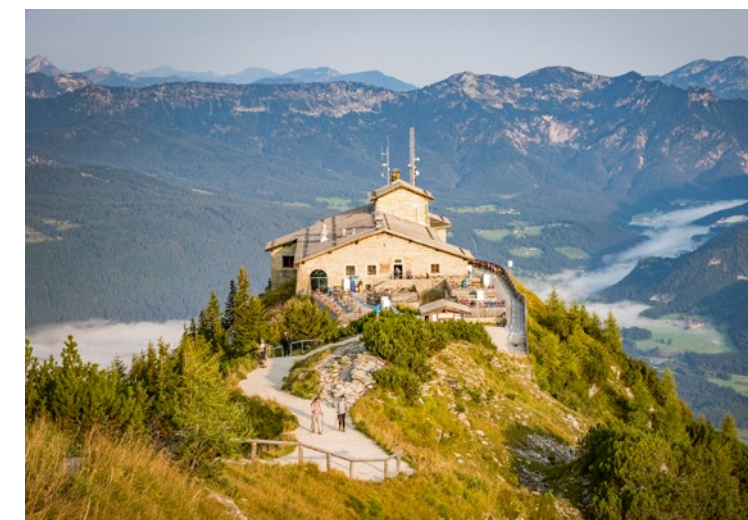
In neuem Glanz erstrahlt das Kehlsteinhaus nach umfassender Renovierung im Mai diesen Jahres
