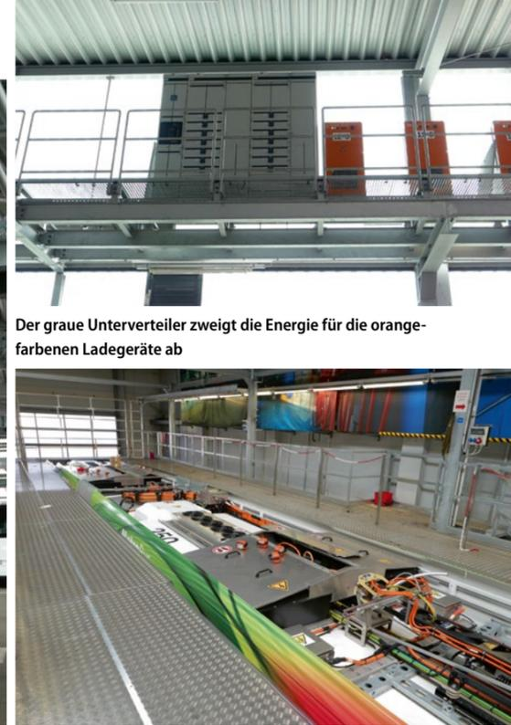
Der graue Unterverteiler zweigt die Energie für die orange-farbenen Ladegeräte ab
