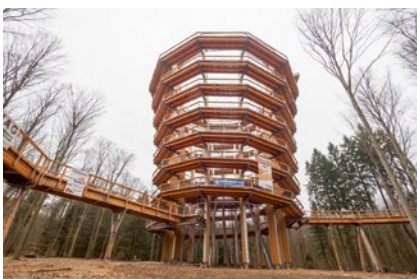
Der Turm des Baumwipfelpfads Steigerwald
